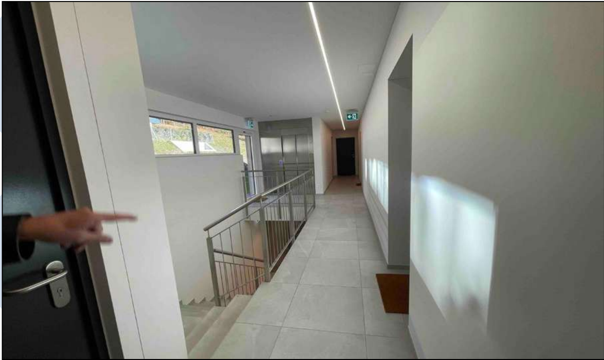
parti comuni (ingresso pedonale 1° piano)
